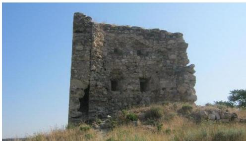
В этом аспекте показательны развалины крепости Каламита в Инкермане (окрестности Севастополя): фотография слева. Крепость в своём первоначальном виде была построена в эпоху до массового применения артиллерии (1427 г.), и соответственно стены её были относительно тонкими.
